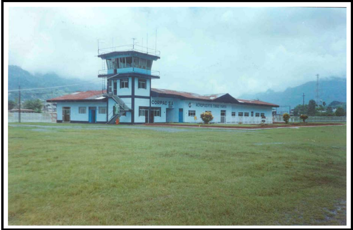
Frontis interior del Aeropuerto de Tingo María
