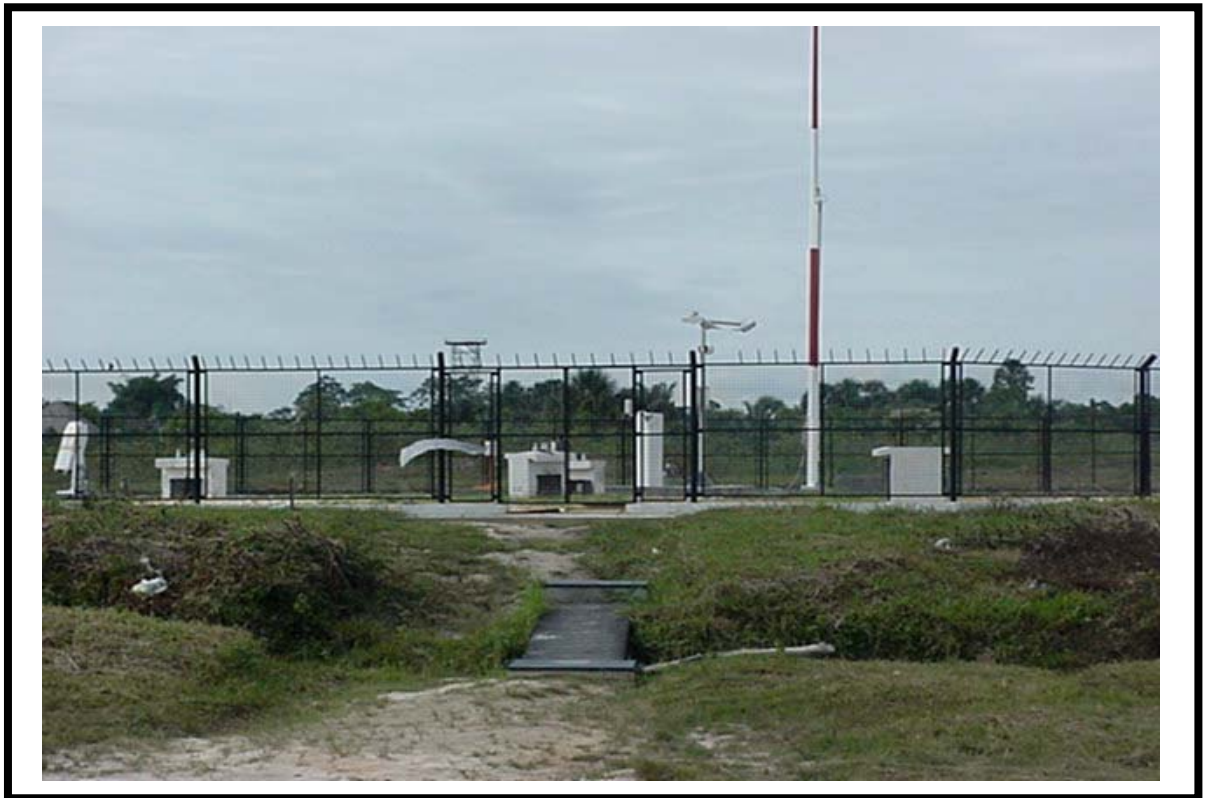
Instalación Sistema AWOS II en el Aeropuerto Internacional de Iquitos
