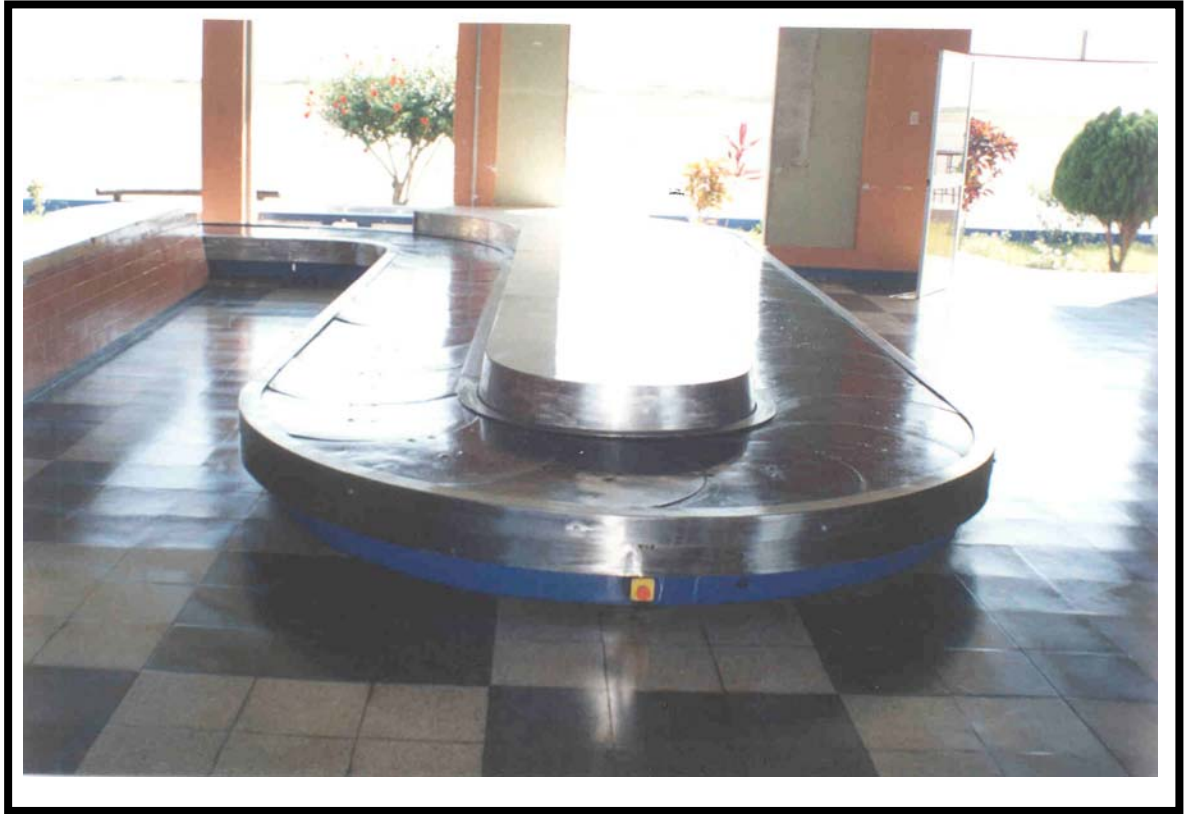
Nueva Faja Transportadora de equipajes del Aeropuerto de Tumbes
