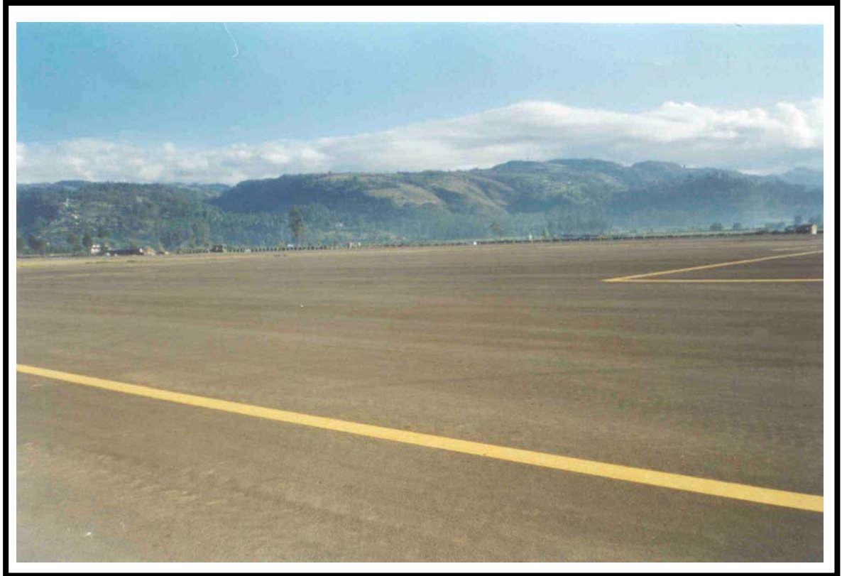
Rehabilitación y Ampliación de la Pista de Aterrizaje del Aeropuerto de Cajamarca
