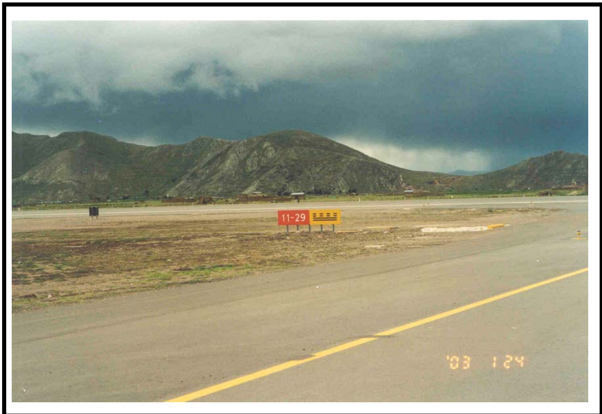
Señalización vertical en la pista de aterrizaje del Aeropuerto Internacional de Juliaca
