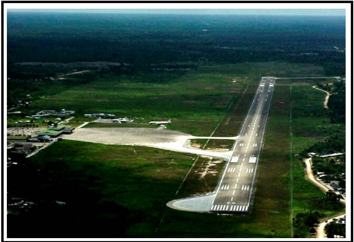
Nueva Construcción de calles de rodaje y Gota de volteo en Aeropuerto Internacional de Iquitos
