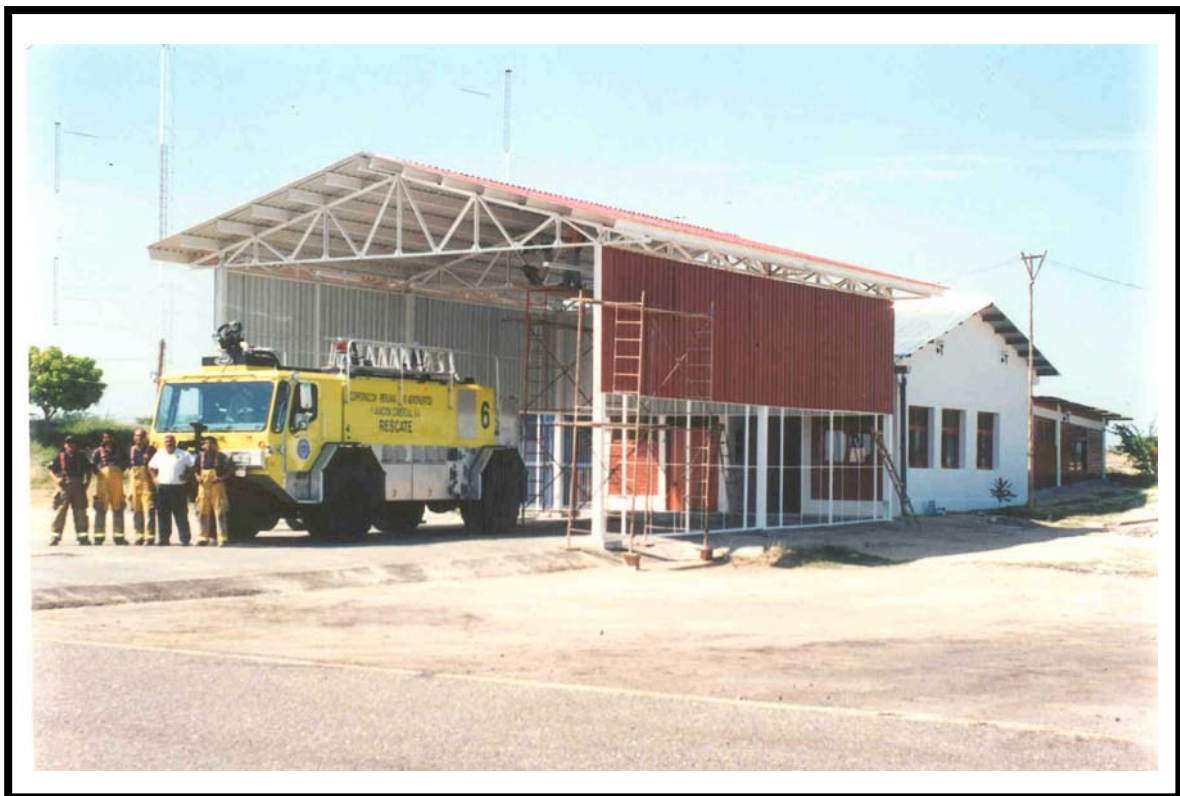
Construcción de la Estación SEI del Aeropuerto de Tumbes
