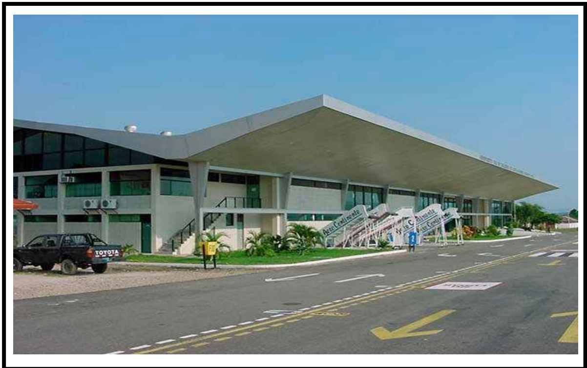
Frontis interior del Aeropuerto de Tarapoto
